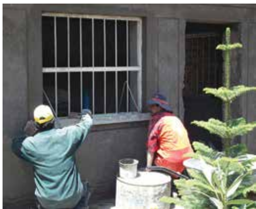
Prace remontowe, fot. K. Kuklińska
