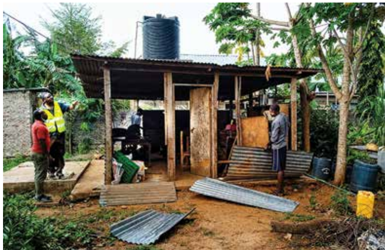
Budynek kuchenny przed remontem, fot. F. Mbula
