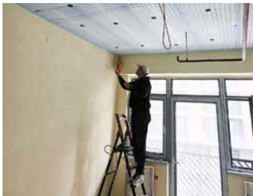
Wykańczanie budynku, fot. W. Szulczyński
